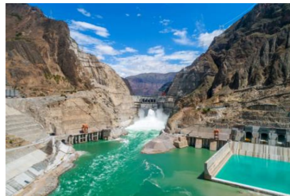
三峡乌东德水电站
